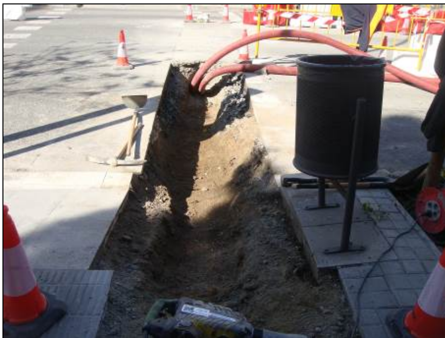
Imatge 5: Continuació Rasa 1
