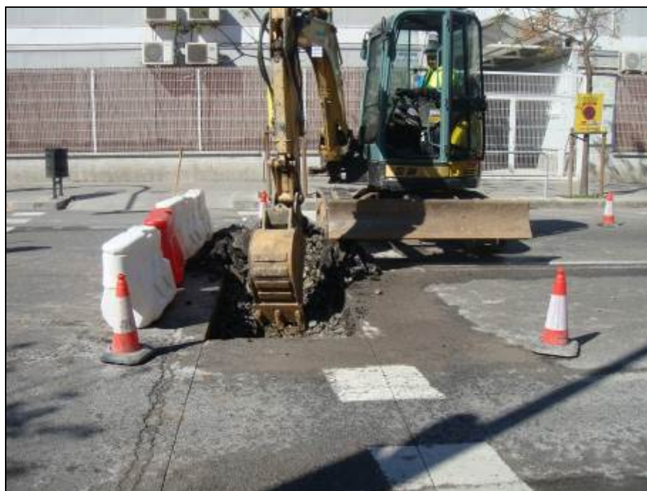
Imatge 2: Picant el paviment de la Rasa 1.
