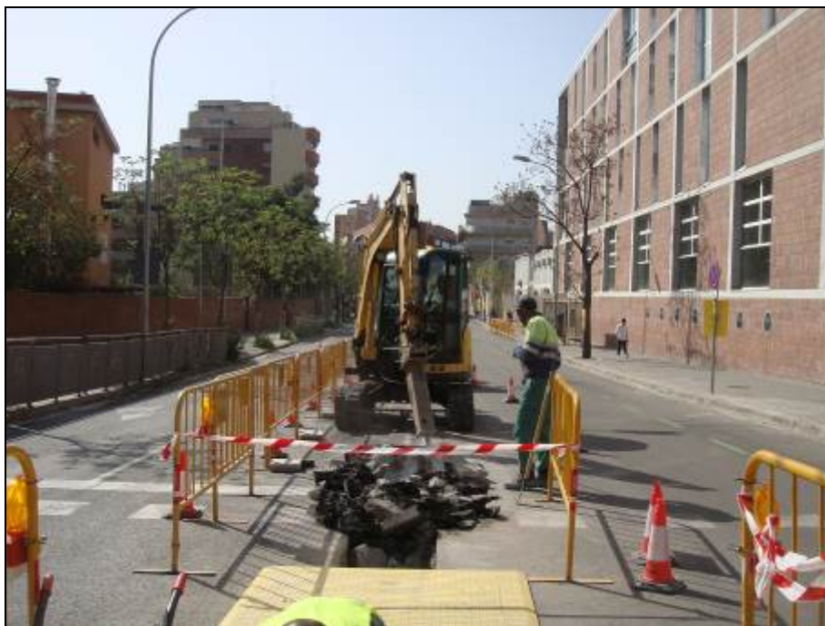
Imatge 7: Picant el paviment de la Rasa 4
