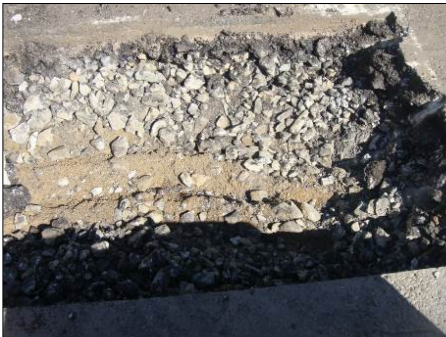
Imatge 3: Detall de la preparació del paviment de la calçada del carrer del Segre.
