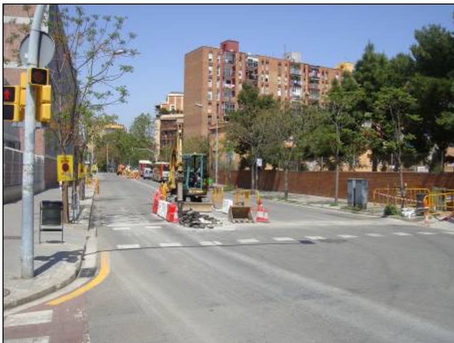
Imatge 9: Picant el paviment de la Rasa 2, general
